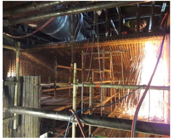
Travaux chaudière parcours 1 Ligne 2
