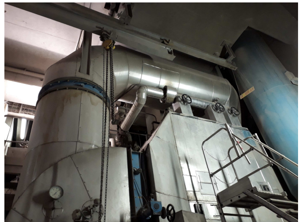
Mise en place de 2 nouveaux réchauffeurs d'air primaire en 2018 sur les Lignes DM Emeraude
